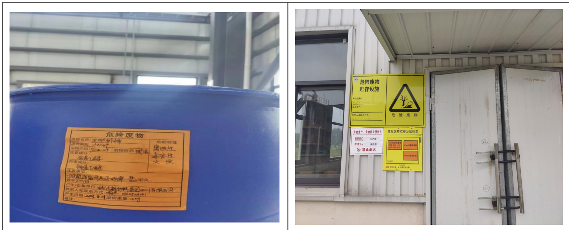
图 4.4-1 危废间现场照片
